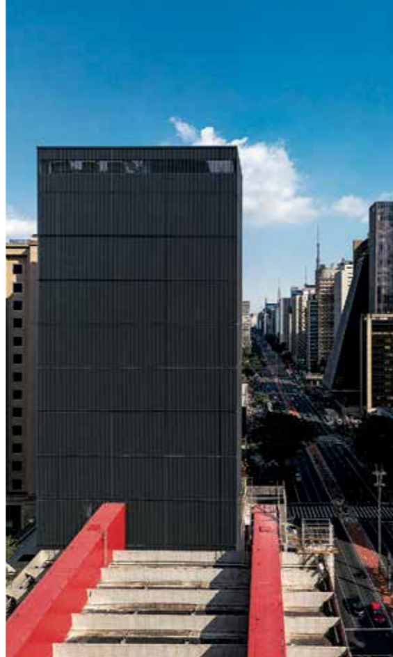
Vista da fachada lateral do novo Edifício Pietro Maria Bardi
